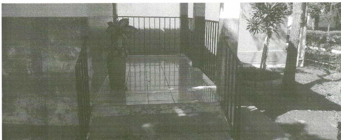
Figura 9 - Guarda corpo da entrada cozinha experimental
